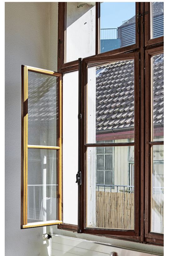
Die Originalbeschläge und das Innenbild des Fensters blieben erhalten. Das hochwertige Isolierglas garantiert Farbechtheit. In Sachen Wohnlichkeit und Energieeffizienz steht das renovierte Fenster einem modernen in nichts nach. BILDER ROMAN WEYENETH
