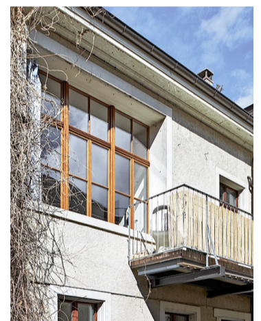
Durch den aussen aufgedoppelten Rahmen sind die Fenster dicht. Die hochwertige Massarbeit lässt das Fenster in neuem Glanz erstrahlen.
