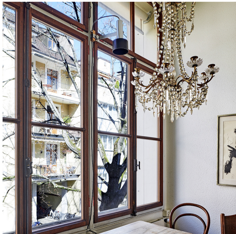
Die Originalbeschläge und das Innenbild des Fensters blieben erhalten. Das hochwertige Isolierglas garantiert Farbechtheit. In Sachen Wohnlichkeit und Energieeffizienz steht das renovierte Fenster einem modernen in nichts nach. BILDER ROMAN WEYENETH
